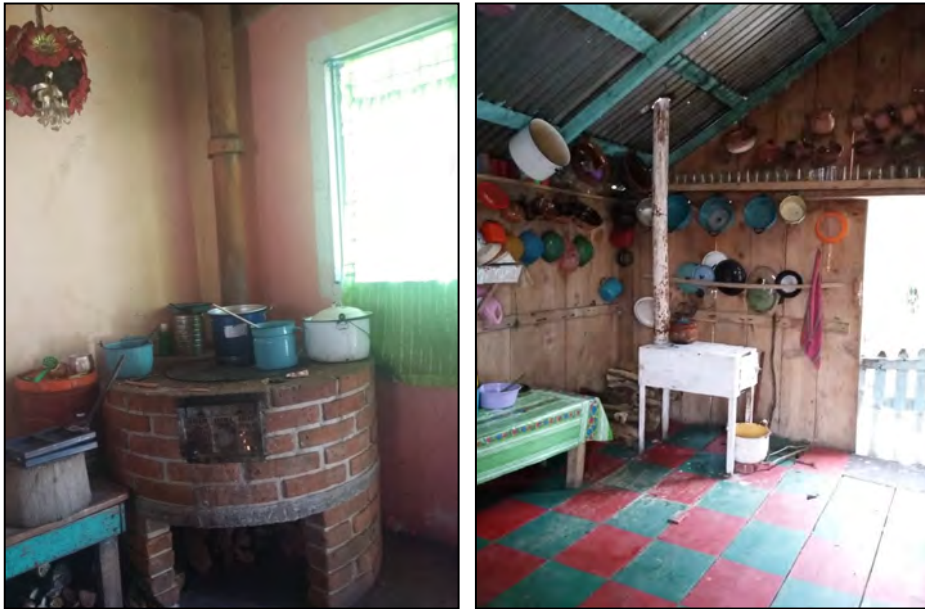
Figura 5.8. Estufas, construidas de lámina y de ladrillo con cemento utilizadas en las comunidades de Buena vista, Coatitlán, Matlalapa y Micoxtla.
